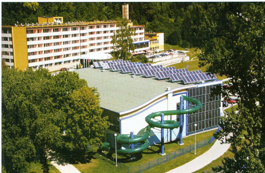
Kolektory słoneczne na ścianie i dachu budynku basenu sportowo-rehabilitacyjnego "Wodny Świat"
