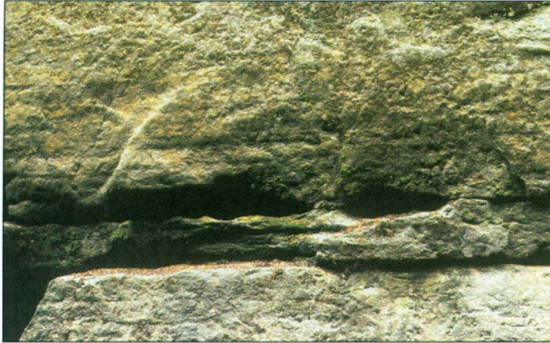
Fot 4 Połka skalna mikrosiedlisko 3 (fot A Smolis)
